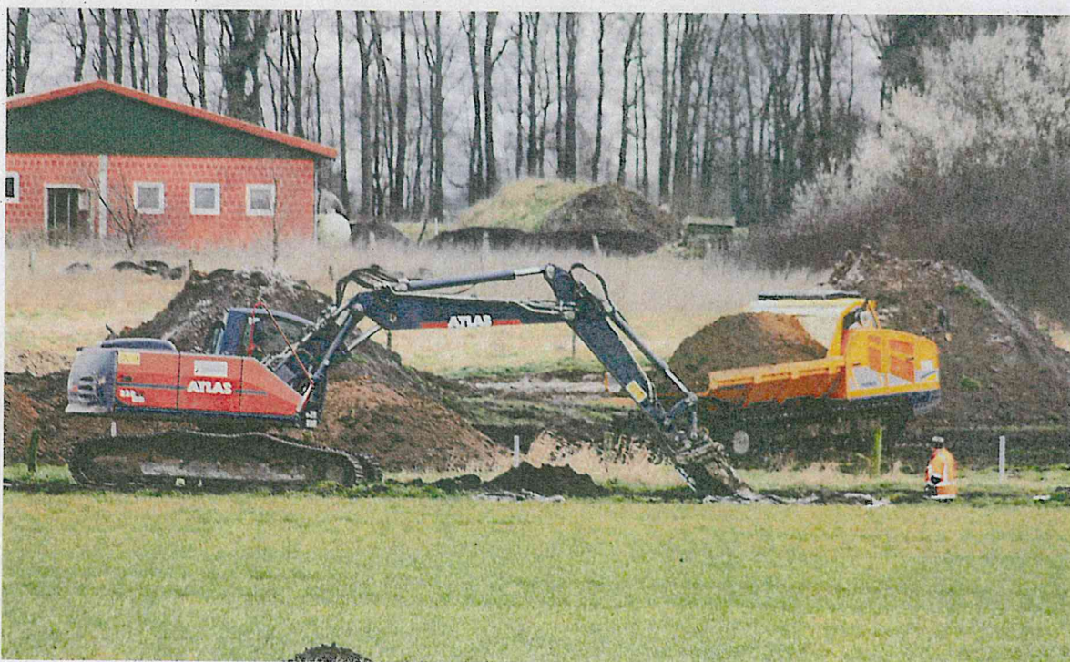
Die Bauarbeiten laufen auf Hochtouren: In Appeln wird ein Regenwasser-Rückhaltebecken gebaut. So soll das Wasser rein werden.
