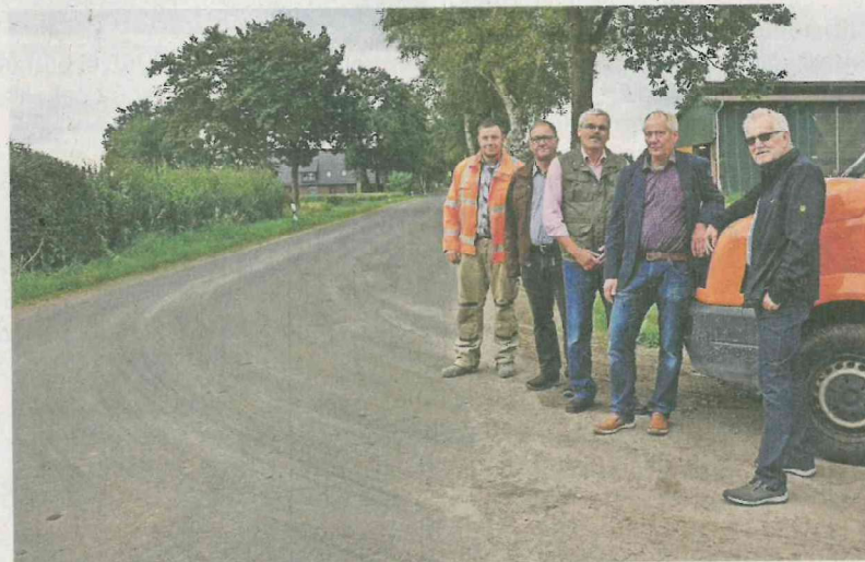
Die gelungene Sanierung der Kreisstraße 41 von Frelsdorf bis Osterndorf sehen sich an (von links): Straßenbauer Jascha Grotheer, Herbert Lührs, Bernd Beckmann, Gerhard Hillmann und Ulf Voigts. Foto Heins
