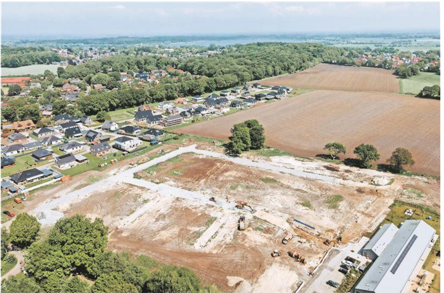
Die Wiesen zwischen dem Neubaugebiet „Hof Eckhoff“ (links) und der Kita „Sonnenblume“ (rechts) sind verschwunden. Der freigeräumte und mit unterirdischen Versorgungsleitungen ausgerüstete Teilabschnitt in Bad Bederkesa kann bald bebaut werden. Foto: Wespa
