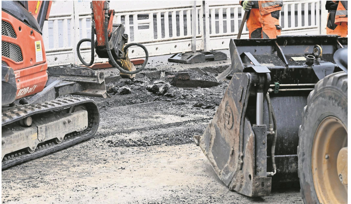
Der Belag einer Straße wird für eine Erneuerung mit einer Baumschneife entfernt, denn auch Straßen können quasi wiederverwendet werden. Recycling spielt eine immer größere Rolle. Foto: Weißbrod/dpa
