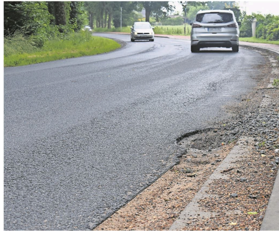
Die viel befahrene L 119 in der Ortsdurchfahrt Fickmühlen: Ab Montag wird die Straße komplett gesperrt. Die Sanierung der Fahrbahn kann beginnen. Foto: Schoener
