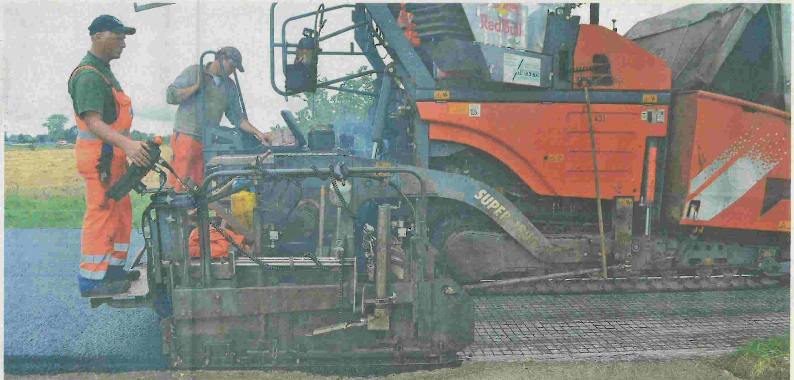
Vorher und nachher im direkten Vergleich: Rechts die abgefräste alte Fahrbahn, links die neue Asphaltdecke.
