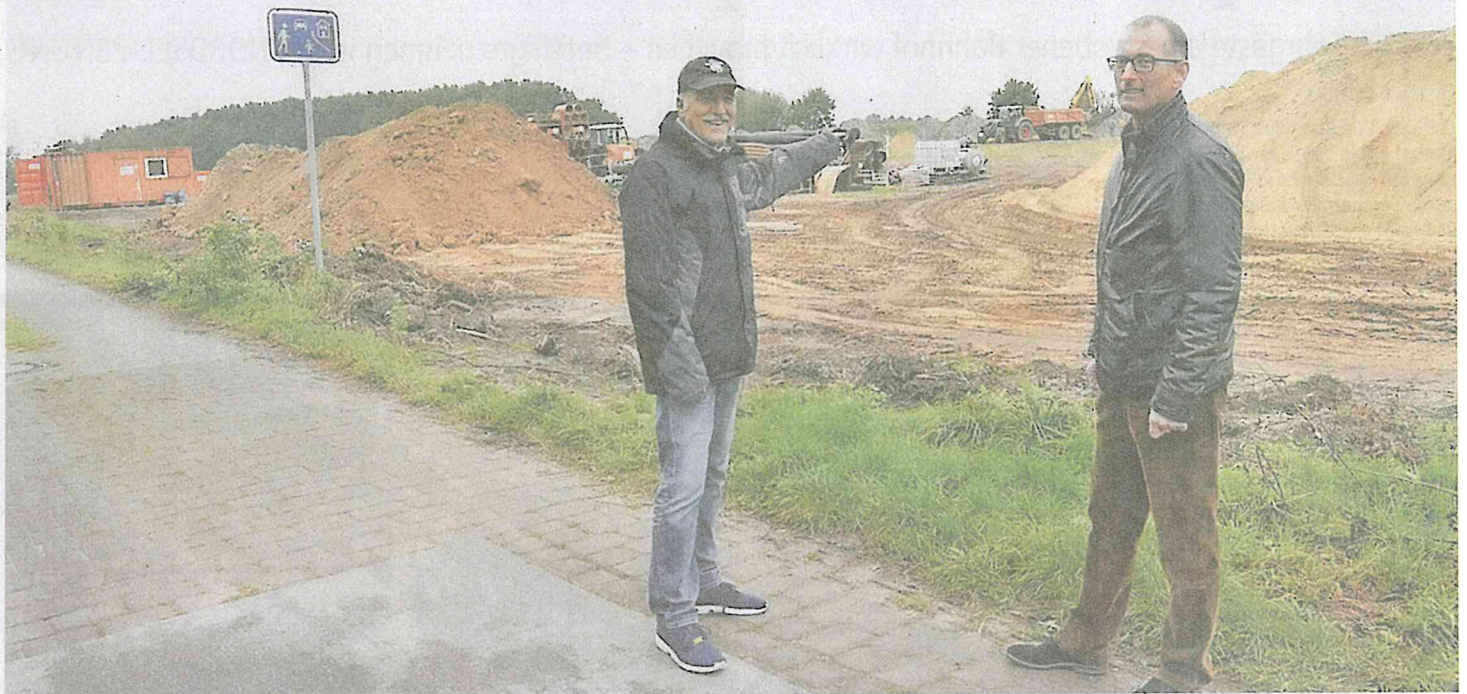
„Das geht ja mächtig voran“: Bürgermeister Detlef Wellbrock (rechts) und Bauamtsleiter Gert Alljets (links) freuen sich. Die Erschließungsarbeiten für das neue Baugebiet in Nesse laufen auf Hochtouren, bis Ende Februar müssen die Arbeiter fertig sein. Dann herrscht wegen der Brutzeit von Waldohreulen Bauverbot, ab Juni 2016 können die Häuser gebaut werden. Foto Schmonsees
